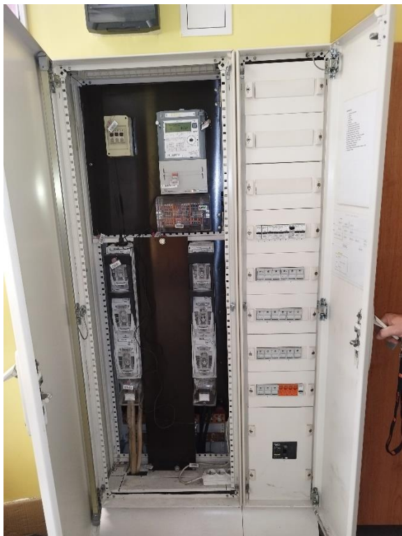
Figura 6 Rozdzielnia z głównymi zabezpieczeniami
